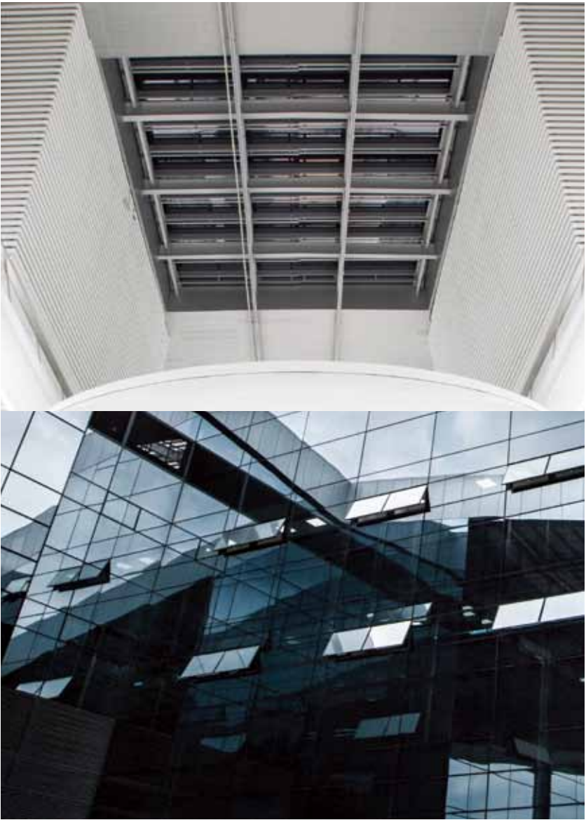
유리 상자의 딜레마. 빛이 무차별적으로 들어오니 건물 내부 온도는 온실처럼 올라가 에너지 소모도 크고 공기 질도 낮아진다. 이에 반해 테크노돔은 빗물 들일 부분은 뚫고 막을 부분은 가렸으며, 열릴 부분은 잘 열고 닫을 부분은 잘 닫아 온실화도 억제하고 쾌적함을 높였다.
