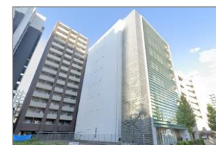
Технический центр в Японии
